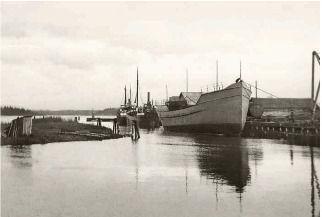
Ett av varvets nybyggen utrustas i Åmåls gamla hamn. Bogsrades sedan till Göteborg för maskininstallation. Foto från Fotopumpen, Läns-pumpens arkiv.
