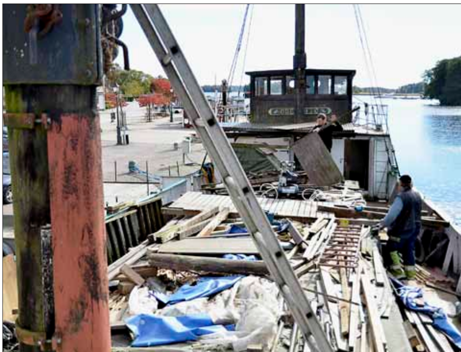
Under hösten 2015 förbereddes upphuggningen av av skutan. Foto Göran Kempe/NA.
