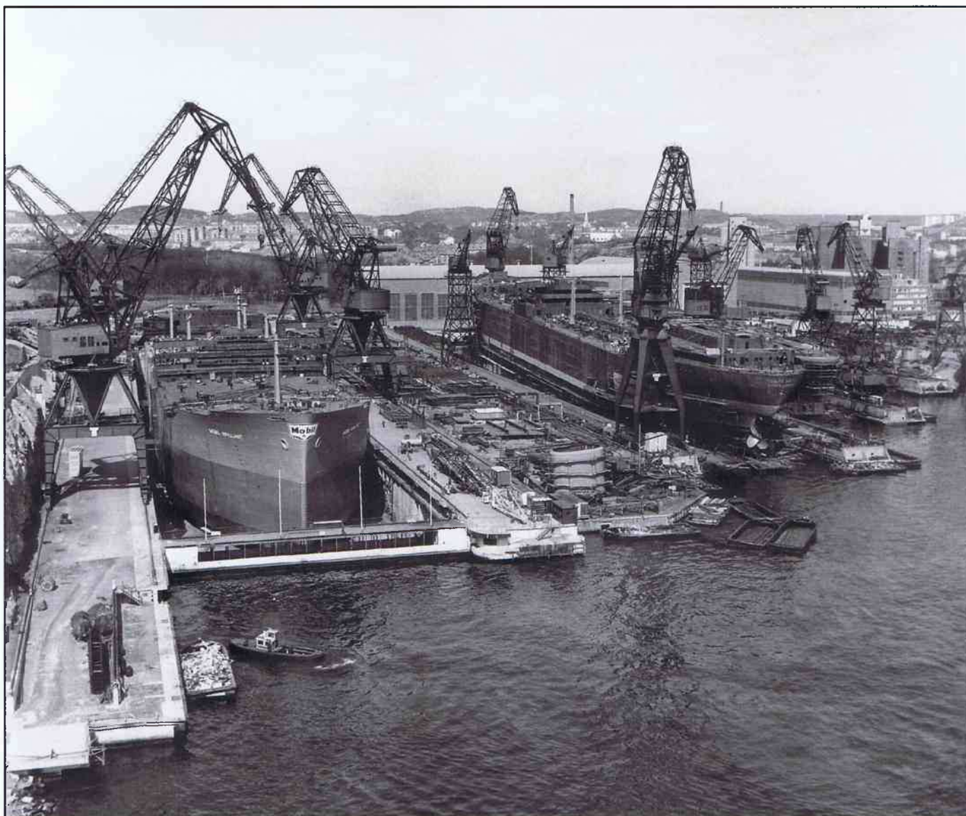
Det är vår 1963 och Mobil Brilliant är nästan färdigbyggd i dockan. Hon är stor, tar nästan upp hela dockans längd och bredd. Full aktivitet råder på varvet på staplar och i verkstäder. Dockan kom sedan att breddas och förlängas innan varvsepoken var till ända.
