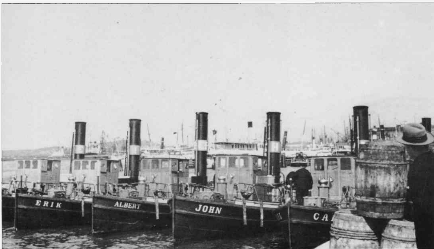
Fem av Röda Bolagets hamnbogserare vid Skeppsbron i Göteborg, där kontoret låg och man väntade på arbetsorder. Alla fem är byggda på Lundby och yttersta båten är med all sannolikhet Robert . Bildarkiv: Göteborgs Historiska Museum.
