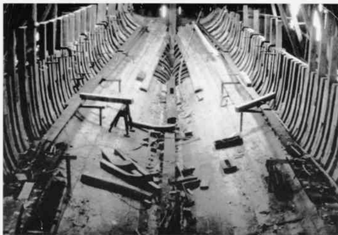
Garnering och uppsättning av brädgångsstöttor pågår.
