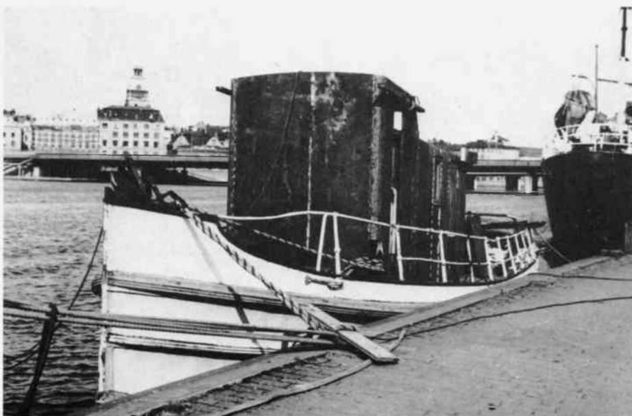
Ombyggnadsarbeten på Torsten 1975. Foto Gunnar Hedman.
