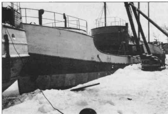
Isländska fiskefartyget Hafdis under utrustning. Däcksbyggnaden har kommit på plats.
