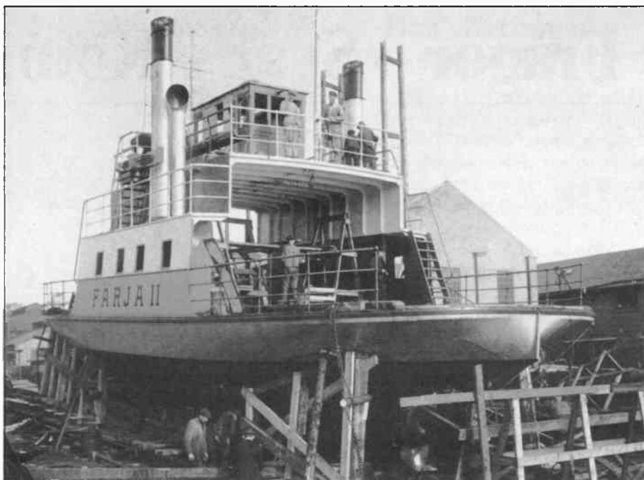
Arbeten in i det sista före sjösättningen. Det målas, arbetas på stapeln och rivs ställningar, allt under överseende av någon tjänsteman. Foto: Eriksbergs Varv.
