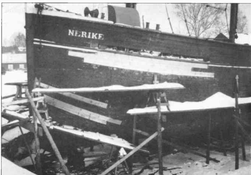
Kanalpesen Nerike från Göteborg har fått utbytt några bordsplankor under vinterupläggningen i Sjötorp.
