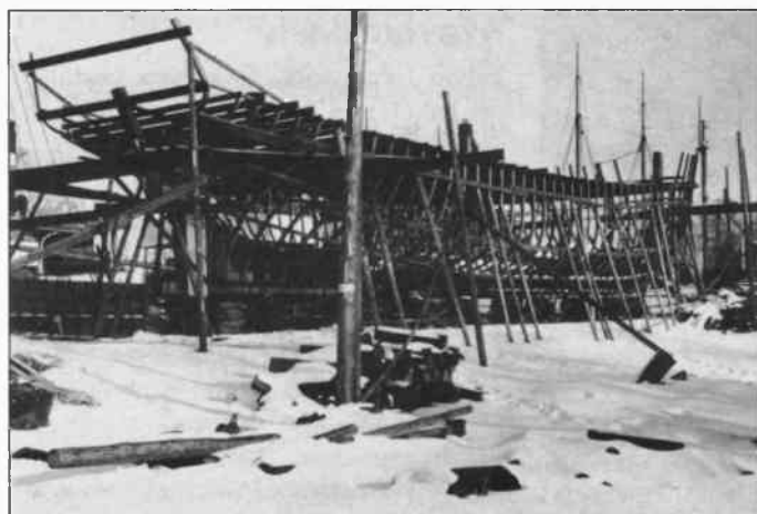
Ett kompositbygge under byggnad. Akterspegelns fina form syns tydligt och även skrovets vackra linjer.
