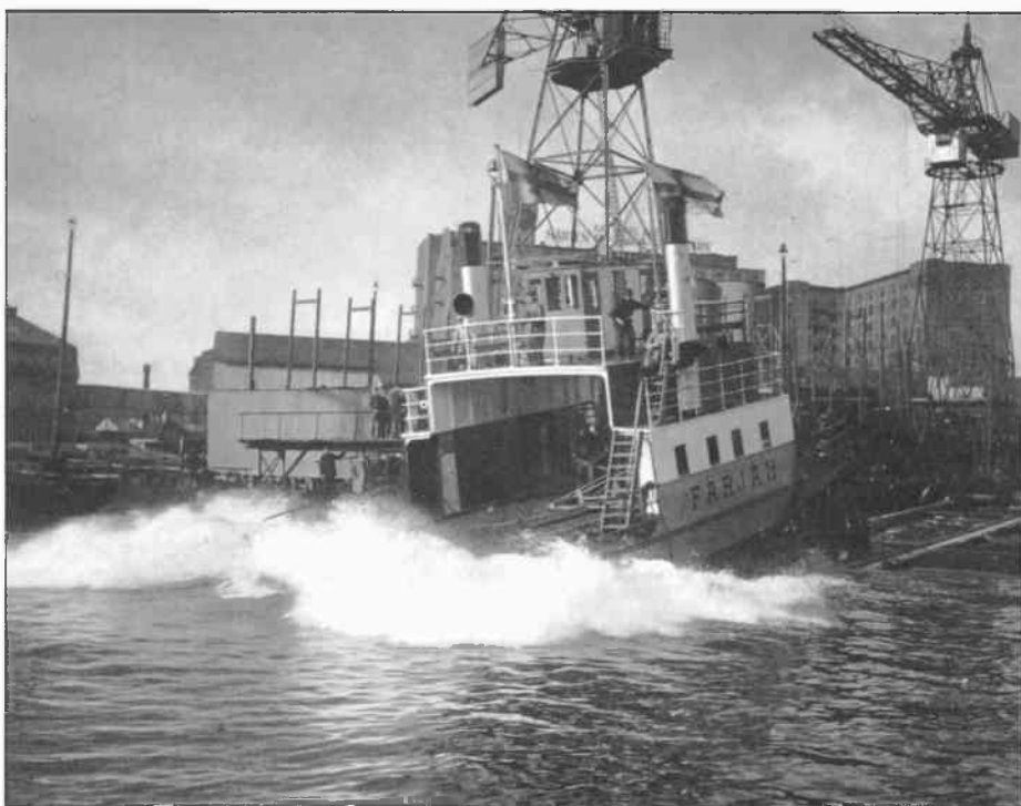
Nybygge 212 går i sjön på Eriksbergs Varv 1923. Foto: Eriksbergs Varv.
