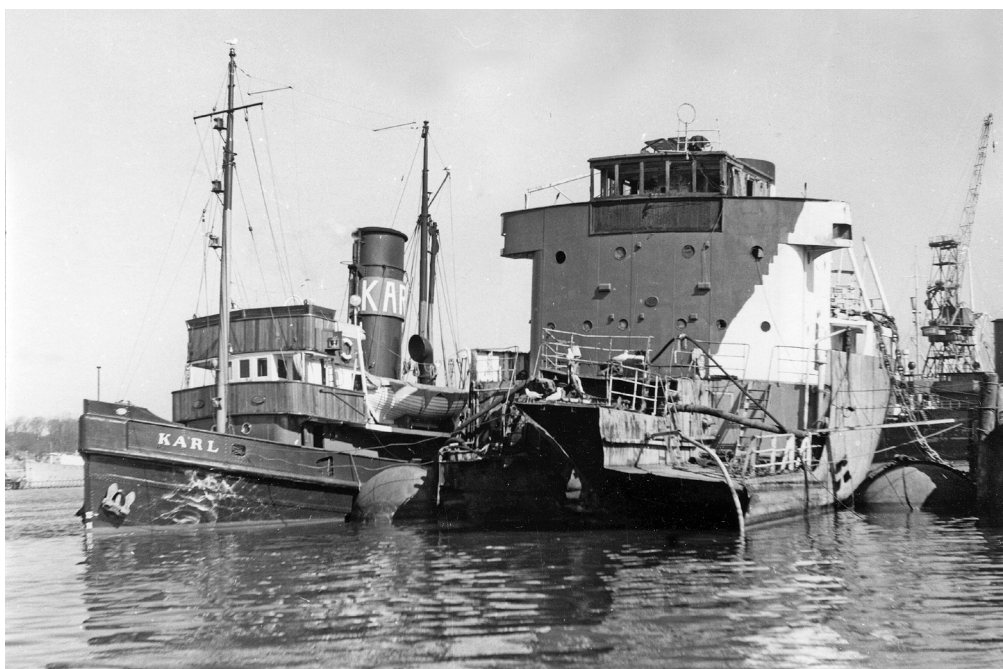
Karl vid bärgade tankern Gustaf Reuter, som exploderade i Ryahamnen, vid bogserbåtshamnen Kusten. Observera pontonerna som håller tankern flytande. Foto Dag Almém 19 april 1954.
