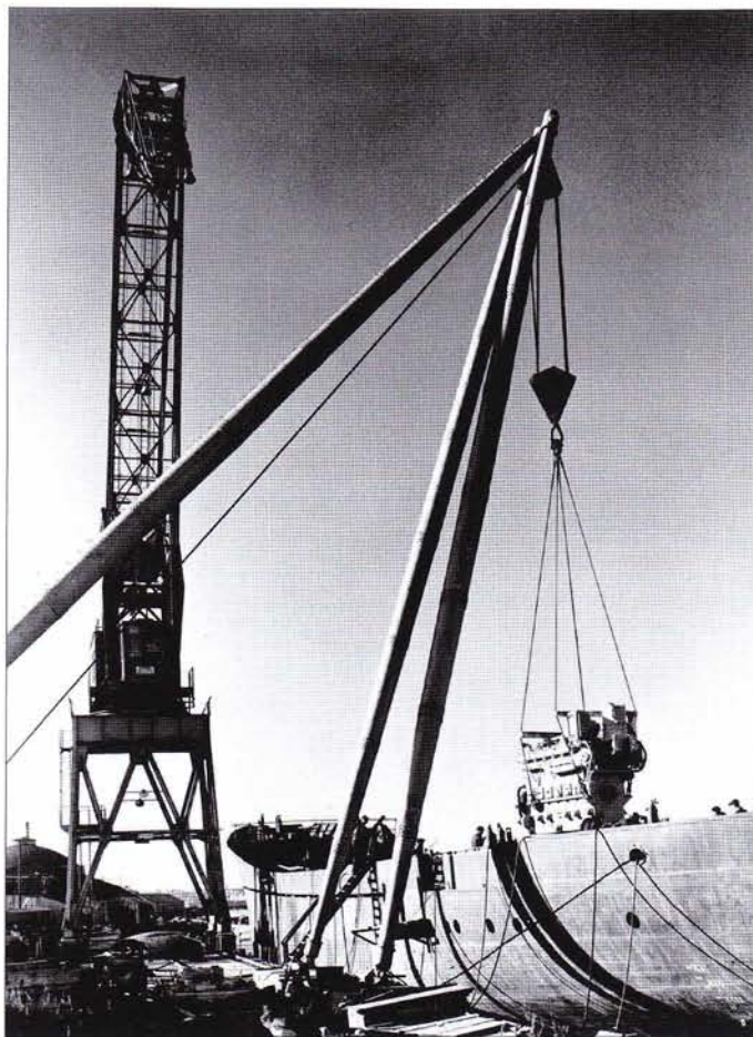
Huvudmotorn lyfts ombord på ett nybygge av Royal-båtarna. Det gällde att inte törna emot och skada motorn.
