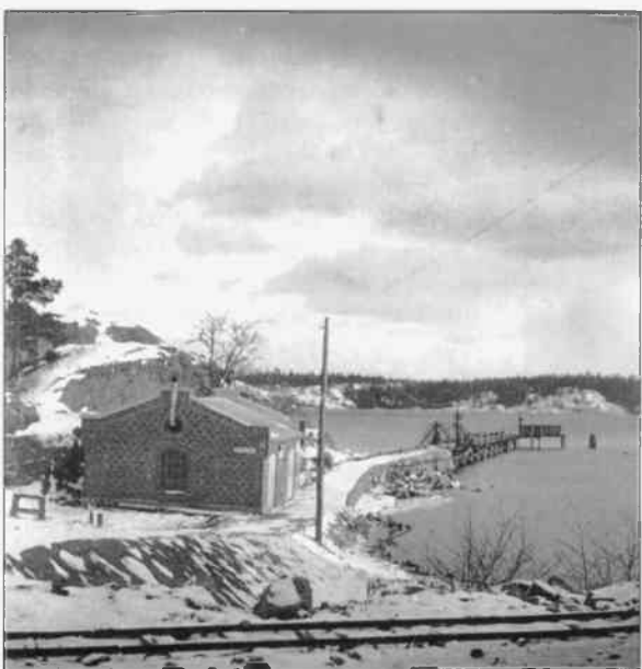
Kajen med pumphuset i Nynäs.
