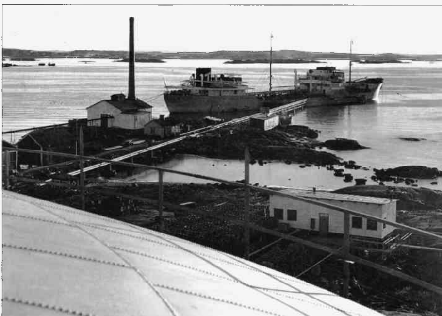
En ny oceankaj blev färdig omkring 1948 på Hjärtholmen. Rederi AB Transoceans motor-tanker Oljaren pumpar sin last till cisternerna.
