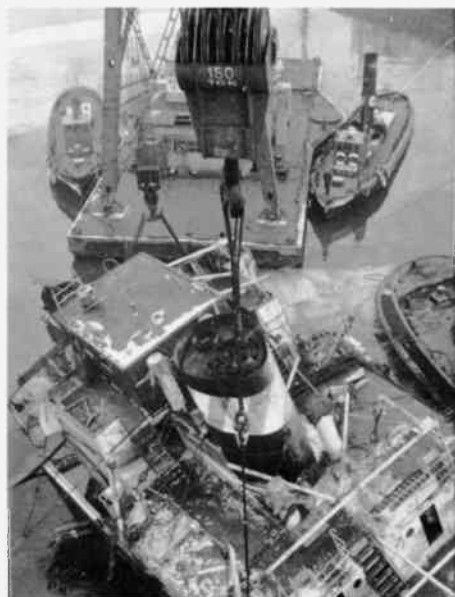
Resterna av Gustaf Reuter hänger säkert i Wajrarna från Hammens båda pontonkranar. Foto från Röda Bolaget.
