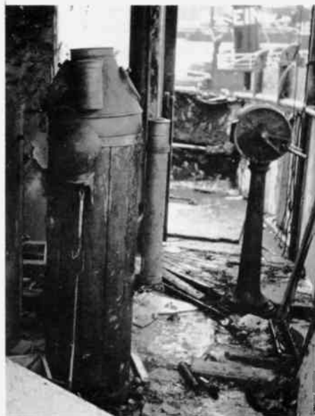
Kommandobryggan blev utblåst vid explosionen och svårt skadad vid den efterföljande branden. Foto:Röda Bolaget.
