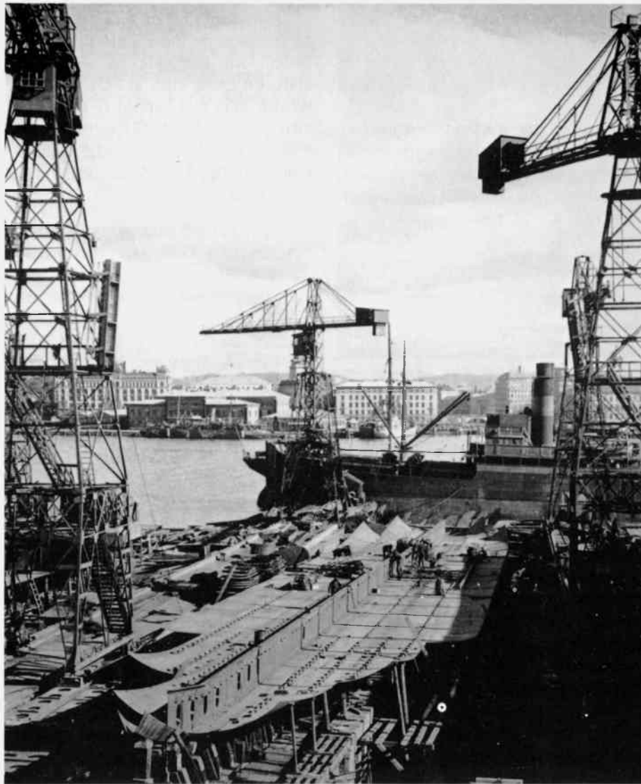
Kölsträckningen är avklarad och bottenplåtarna utlagda. Vid Packhuskajen skymtar ubåtsdepåfartyget H 72 Thjelvar.
