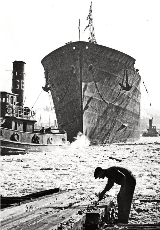
Så fort skrovet gled ned i issörjan började man göra ren stapeln för nästa kölsträckning.
